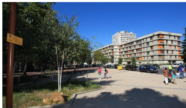
Vue de la place des bouleaux et le prolongement de la rue H. Koch
