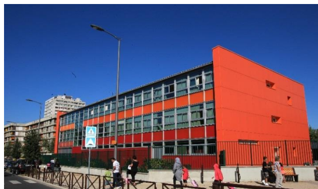
Rénovation du groupe scolaire Charles Beuvin
