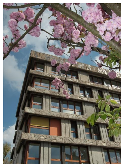
Bâtiment I réhabilité
