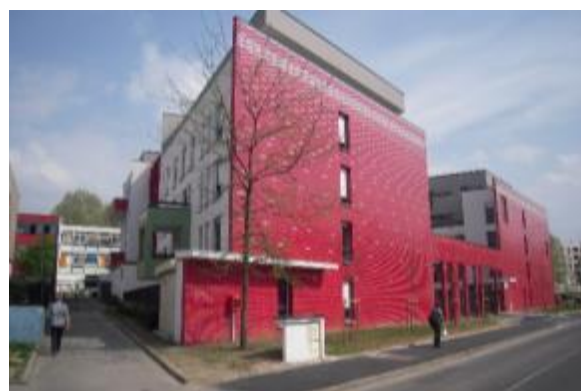
Opération de construction hors site de logements sociaux réalisée par « La Maison du CIL »
